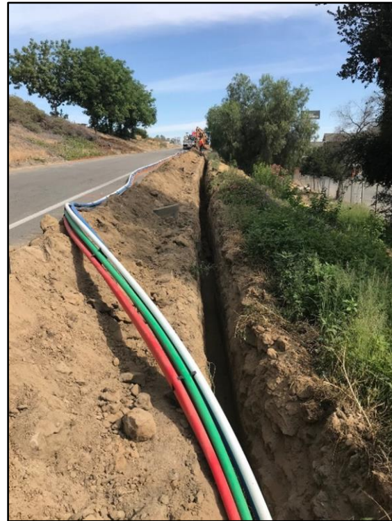
Figure 10. Conduit Placement
